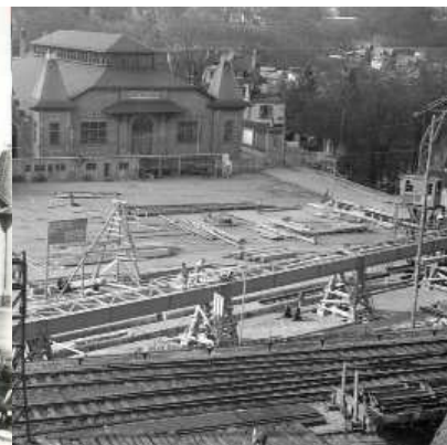
Baustelle Viadukt um 1938
