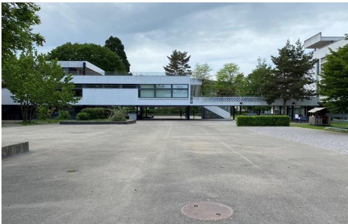
Gebäude 2a, Ostfassade und Passerelle – Sicht aus zentralem Pausenplatz
