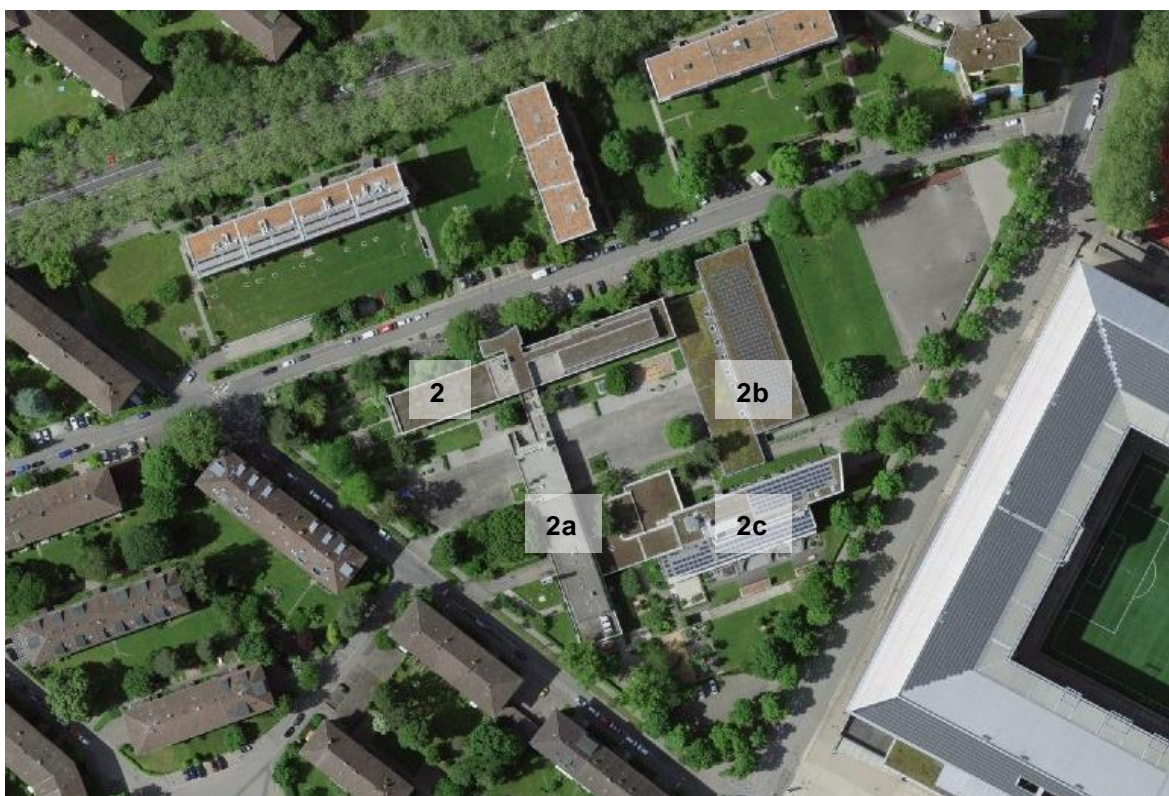
Situation: Morgartenstrasse 2 (Volksschule), 2a (AfU, Ganztagesbasisstufe, Schulleitungsbüros), 2b (Turnhalle) und 2c (Sprachheilschule)
