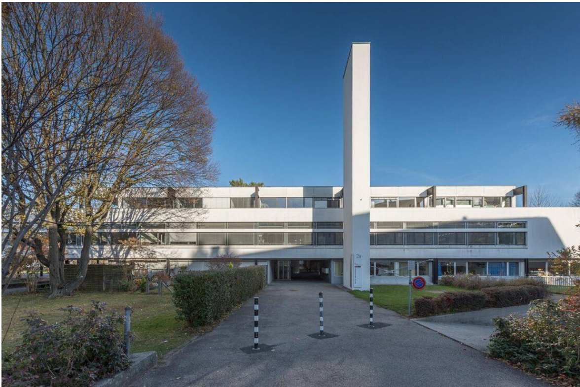
Gebäude 2a, Westfassade und markanter Kamin – aus der Perspektive der Morgartenstrasse betrachtet
