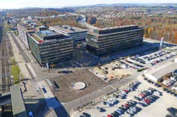
Das Areal WankdorfCity mit Blick Richtung Westen. Das Bild zeigt die vier neuen, in einem ersten Schritt entstandenen Gebäude sowie im Vordergrund den noch unbebauten Arealteil mit dem bereits fertiggestellten Rosalia-Wenger-Platz.
