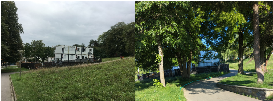
Abbildungen 4 Standort mit aktueller Bauplatzinstallation EWB / Fernwärme
