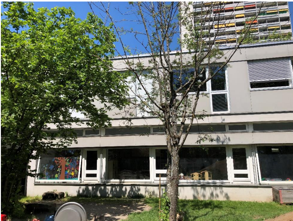
Südfassade, zweigeschossiger Bereich
