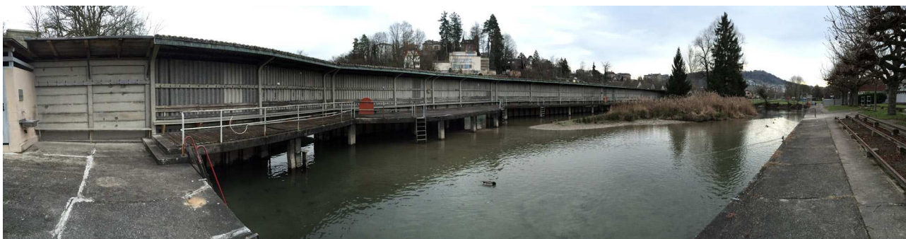
Heutiger Zustand der Anlage mit Verlandung
