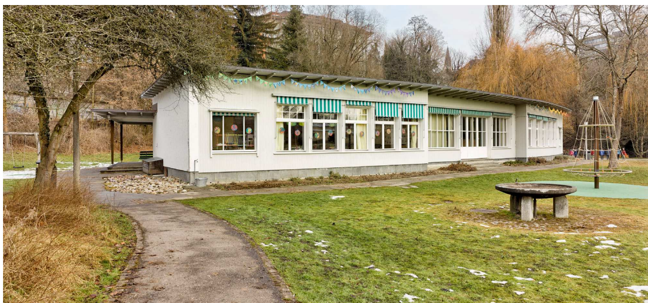
Kindergarten und Unterstufe Pavillon Brückenstrasse 70
