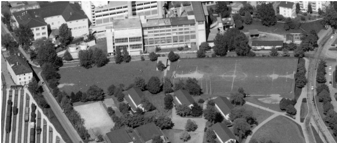
Abbildung 2: Flugaufnahme nach Fertigstellung 1963
