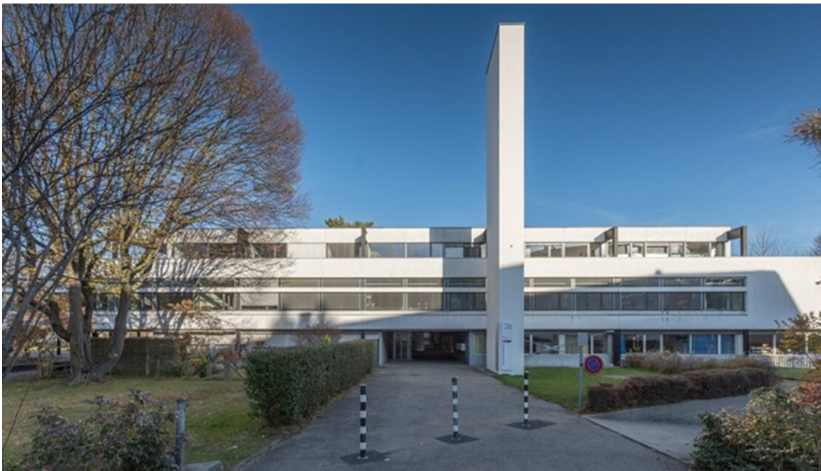
Abbildung 1: Gebäude 2a, Westfassade und markanter Kamin – aus der Perspektive der Morgartenstrasse betrachtet
