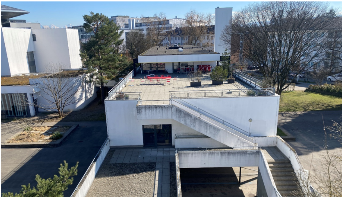
Abbildung 3: Blick auf die Passerelle, Terrasse AfU und Attikageschoss. Die neue PV-Anlage kommt im vorderen Bereich der Terrasse zu liegen.
