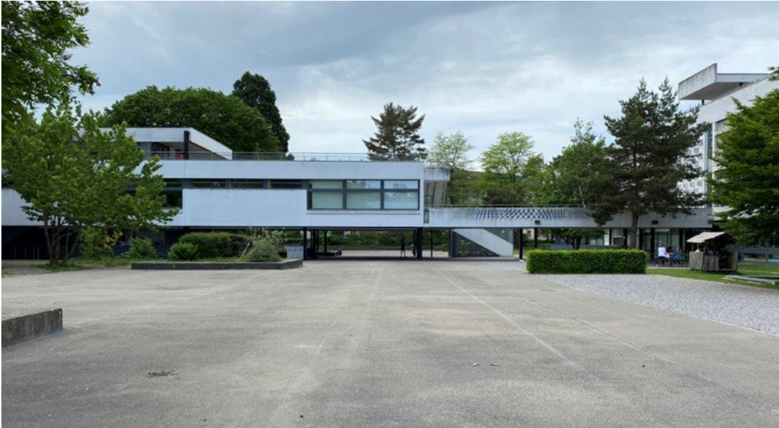
Abbildung 4: Gebäude 2a, Ostfassade und Passerelle – Sicht vom zentralen Pausenplatz
