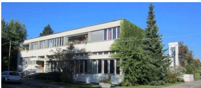
Gemeindefhaus Burgfeld, Burgdorfholzstrasse 35
