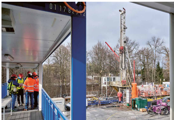
Der Bohrplatz hinter der Energiezentrale Forsthaus.
