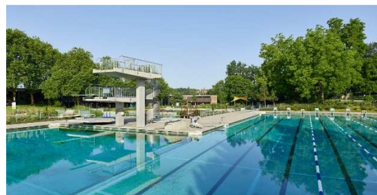
50m-Becken mit Sprungturbereich
