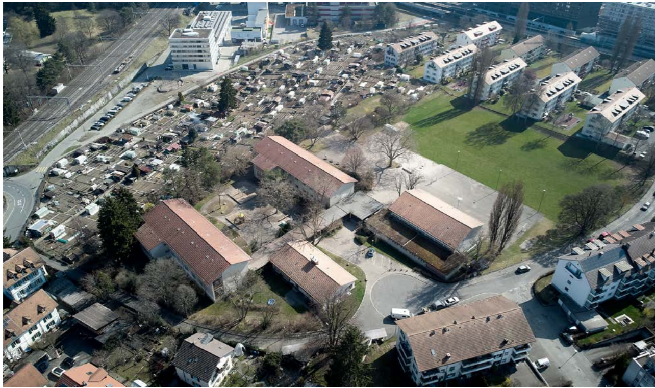
Schulanlage von Oben
