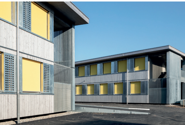
Die Stadt Bern hat gute Erfahrungen gemacht mit Modulbauten aus Holz. Auf dem Foto sind zwei Gebäude des Schulraumprovisoriums Brünnen zu sehen.
