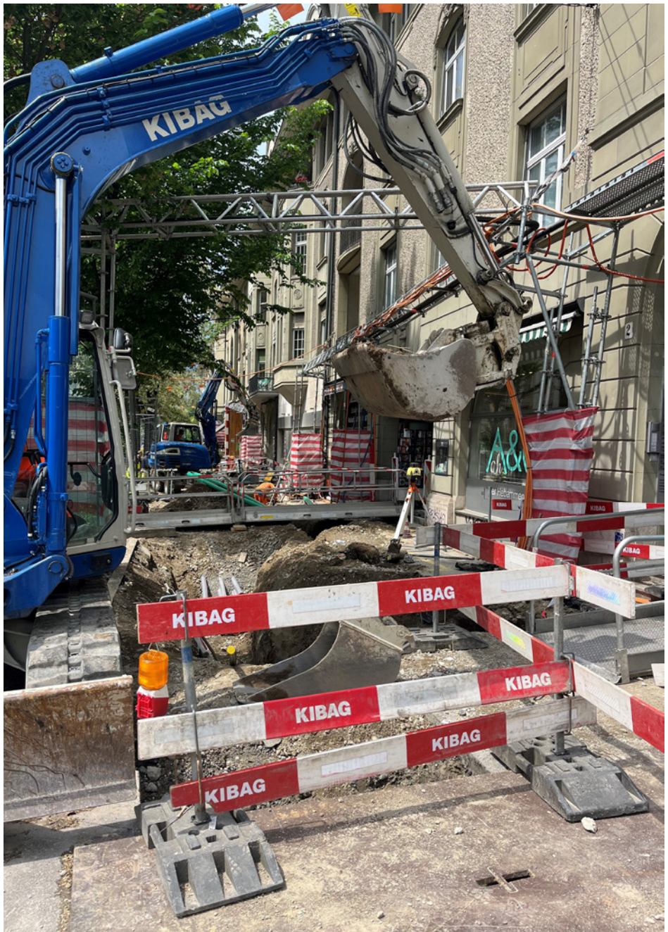
Bauphase Sanierung Effingerstrasse Sommer 2025, Situationsbild beim Hauseingang zur städtischen Ombudsstelle, sinnbildlich für die Frage «Wie finde ich den Zugang zum Recht?» Bild Mirjam Graf
