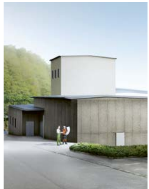
Erneuerung Unterwerk Engehalde
