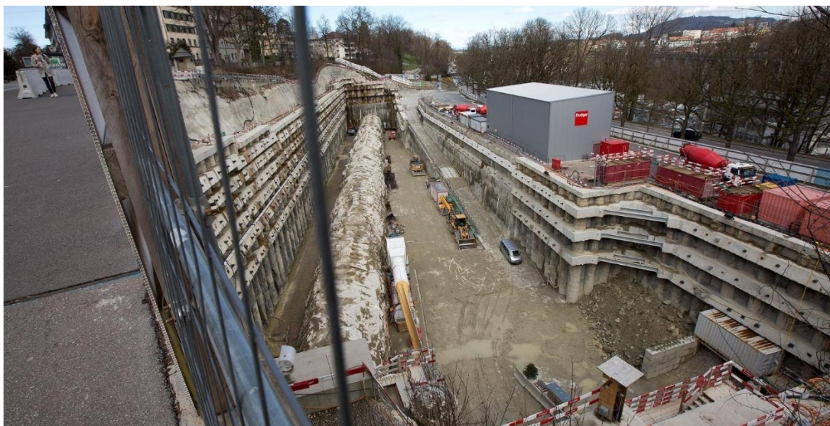
Abbildung 1: Baugrube des RBS 2021, Blick vom Bierhübeli (Bild: I. Andermatt, Langenth. Tagblatt)
