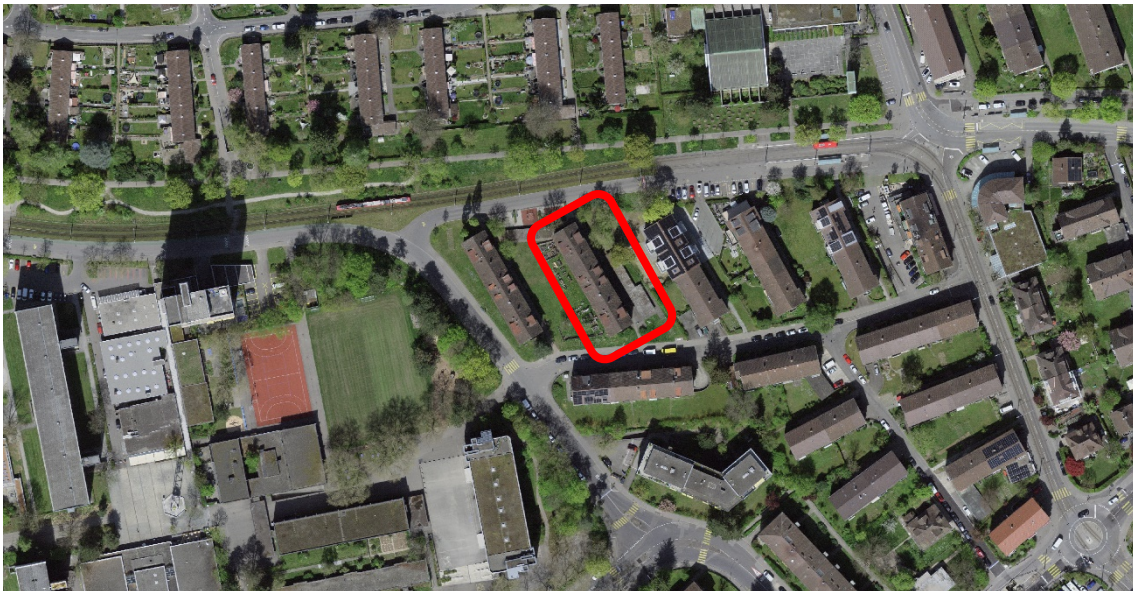
Wohnbauten Zelgstrasse 18, 20, 22 und Nebenbau Zelgstrasse 20a im Quartier Blumenfeld, Bern Bethlehem
