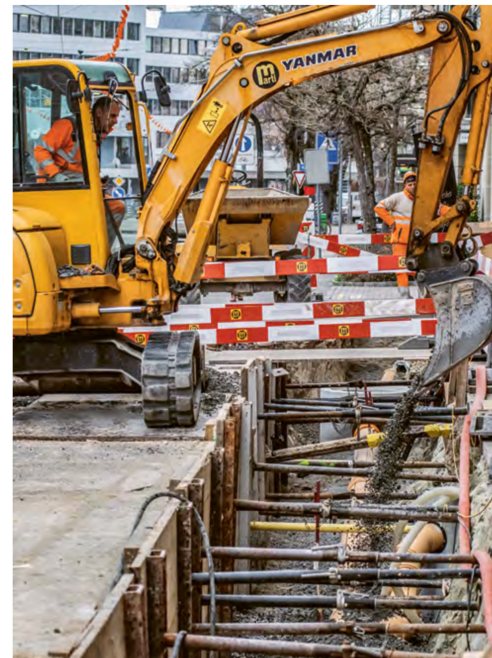
Bild 2 und 3: Werkleitungssanierungen im «nöien Breitsch».
