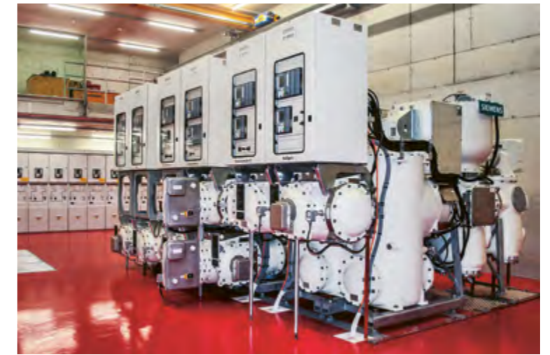
Bild 1: Das neu sanierte Unterwerk Engehalde.
