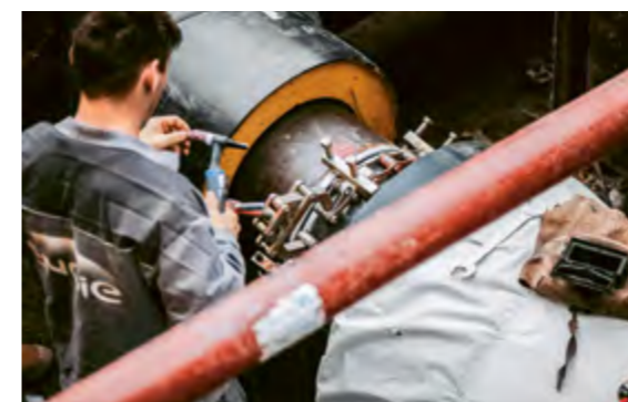
Fernwärme-Rohre werden zusammenschweisst.
