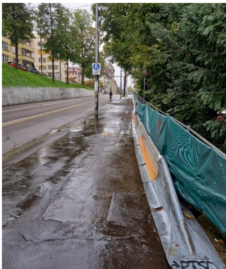
Abbildung 3+4: Bilder des schadhafte Belags an der Neubrückstrasse
