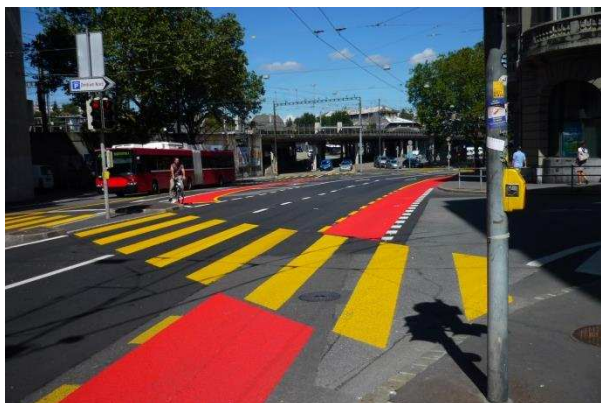
Rote Einfärbung von Velostreifen in Einspur- und Abzweigungsbereiche (Bild: Bollwerk)
