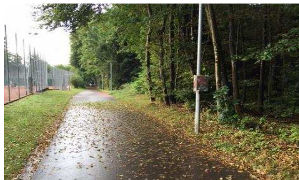
Die Fuss- und Veloverbindung zwischen Thunplatz und Kalcheggweg (beim Dählhölzliwald) wurde verbreitert
