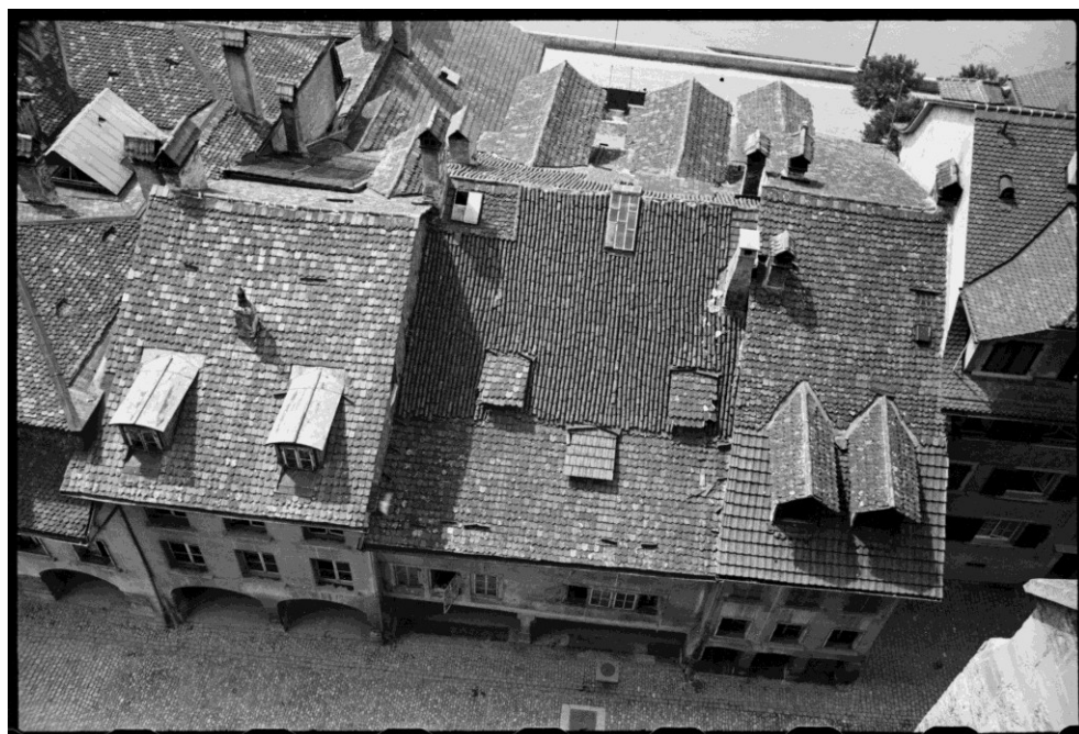
Abbildung 24: Ziegeldächer im Bereich der Häuser Badgasse 5-9, kurz vor dem Abbruch 1931. Auf dieser bemerkenswerten Fotografie wird deutlich, dass in Bern selbst auf kleinem Raum alle hier beschriebenen Techniken und Varietäten von Ziegeldächern vorhanden sein konnten – nebst den vorherrschenden Biberschwänzen Hohlpfannen (Mitte) und Falzziegel (unten rechts).
