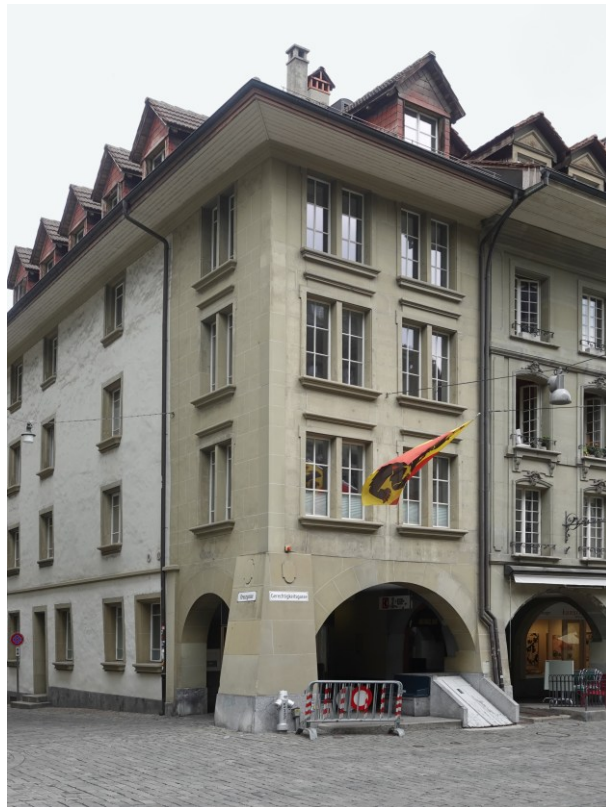
Abbildung 53: Das Eckhaus Gerechtigkeitsgasse 80.
