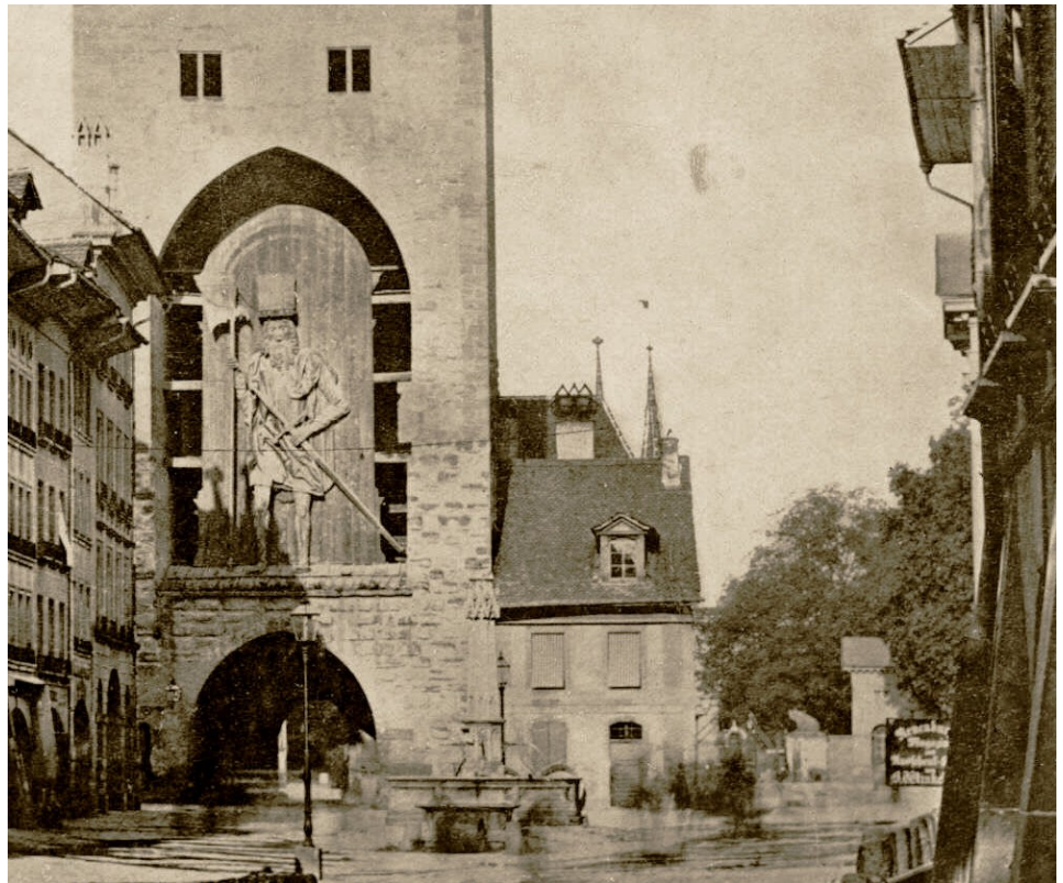
Abbildung 120: Der Christoffelturm von der Spitalgasse aus gesehen, kurz vor dem Abbruch 1865.
