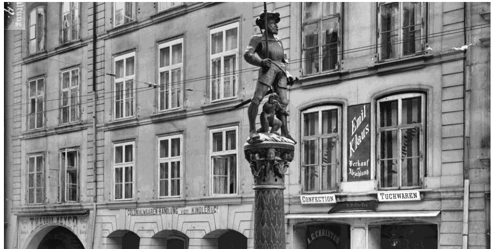
Abbildung 57: Max van Berchem, Bern, Schützenbrunnen um 1900 (Ausschnitt). Winterkonfiguration mit Vorfenstern (Brüstungsgitter und Fensterläden ausgehängt).
