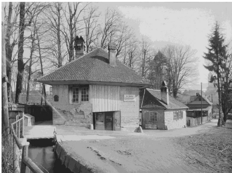
Abbildung 35: Der Stadtbach um 1920 im Bereich der abgebrochenen Liegenschaft Federweg 9.
