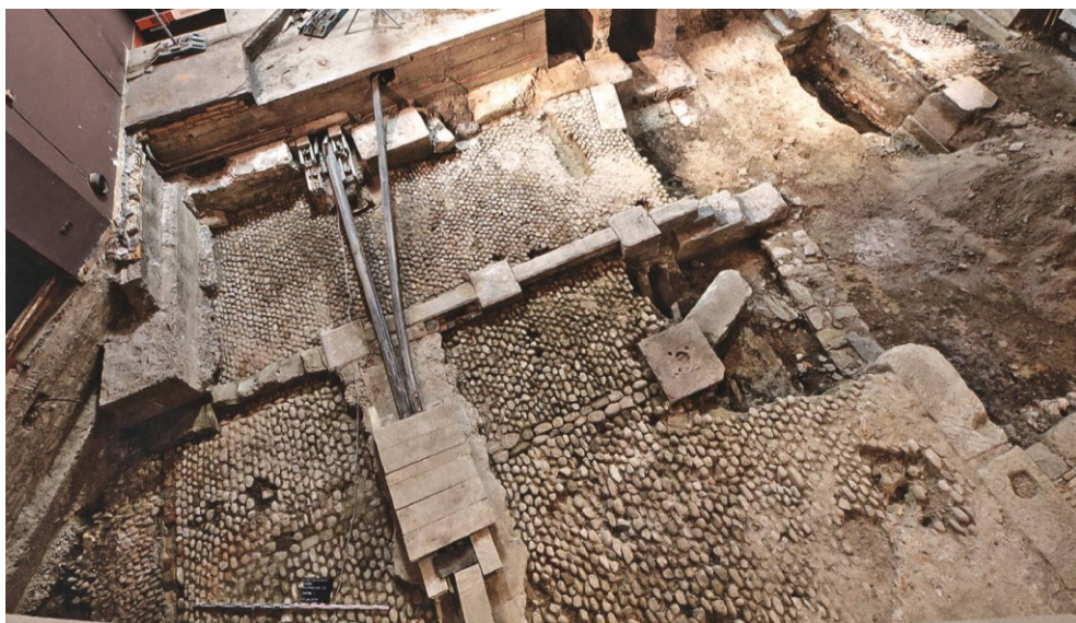
Abbildung 29: Die Grabung im Hof des Hauses Kramgasse 72 (Capitol) von 2020. Der sorgfältig freigelegte Befund zeigt ein besonders schönes, typisches Beispiel einer barocken Pflasterung mit «Kieselsteinen». Hier sind die Steine nach Grössen sortiert, gerichtet, mit eingelegten Bändern gegliedert und zu lebendigen Flächen zusammengesetzt, die an die Epidermis von Lebewesen erinnern.
