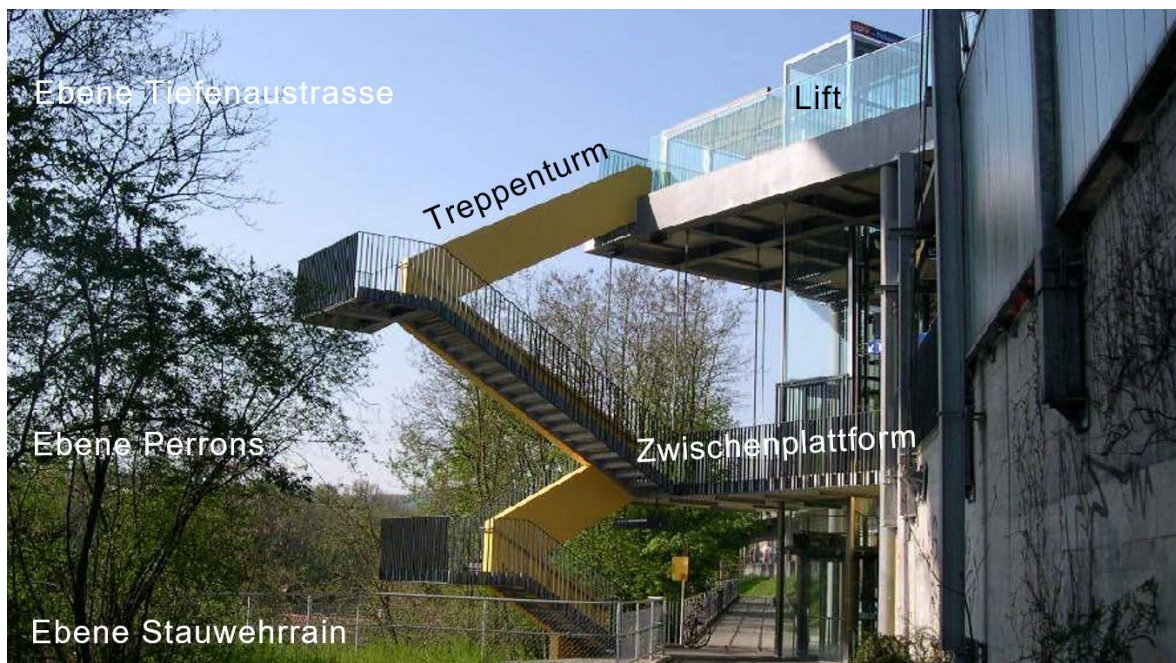
Abbildung 2: Ansicht Station Felsenau (Blickrichtung Stadtzentrum)
