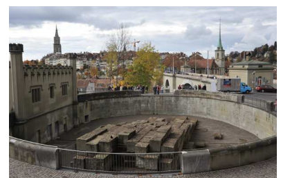
Grosser Bärengraben nach der Sanierung
