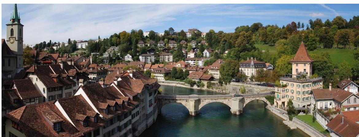
Abb. 1: Lage der Untertorbrücke
