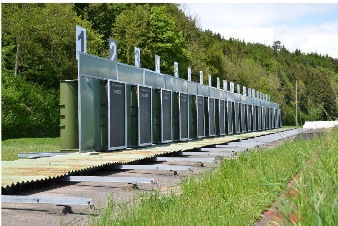
Beispiel eines Scheibenstands mit Kugelfangkästen (Quelle: Bau-, Verkehrs- und Energiedirektion des Kantons Bern)
