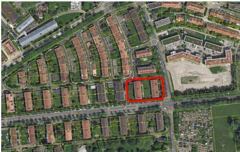
Situation Siedlung Holligen: Schlosstrasse 86/88, a/b (Geb. links) und Huberstrasse 18/20 (Geb. rechts)
