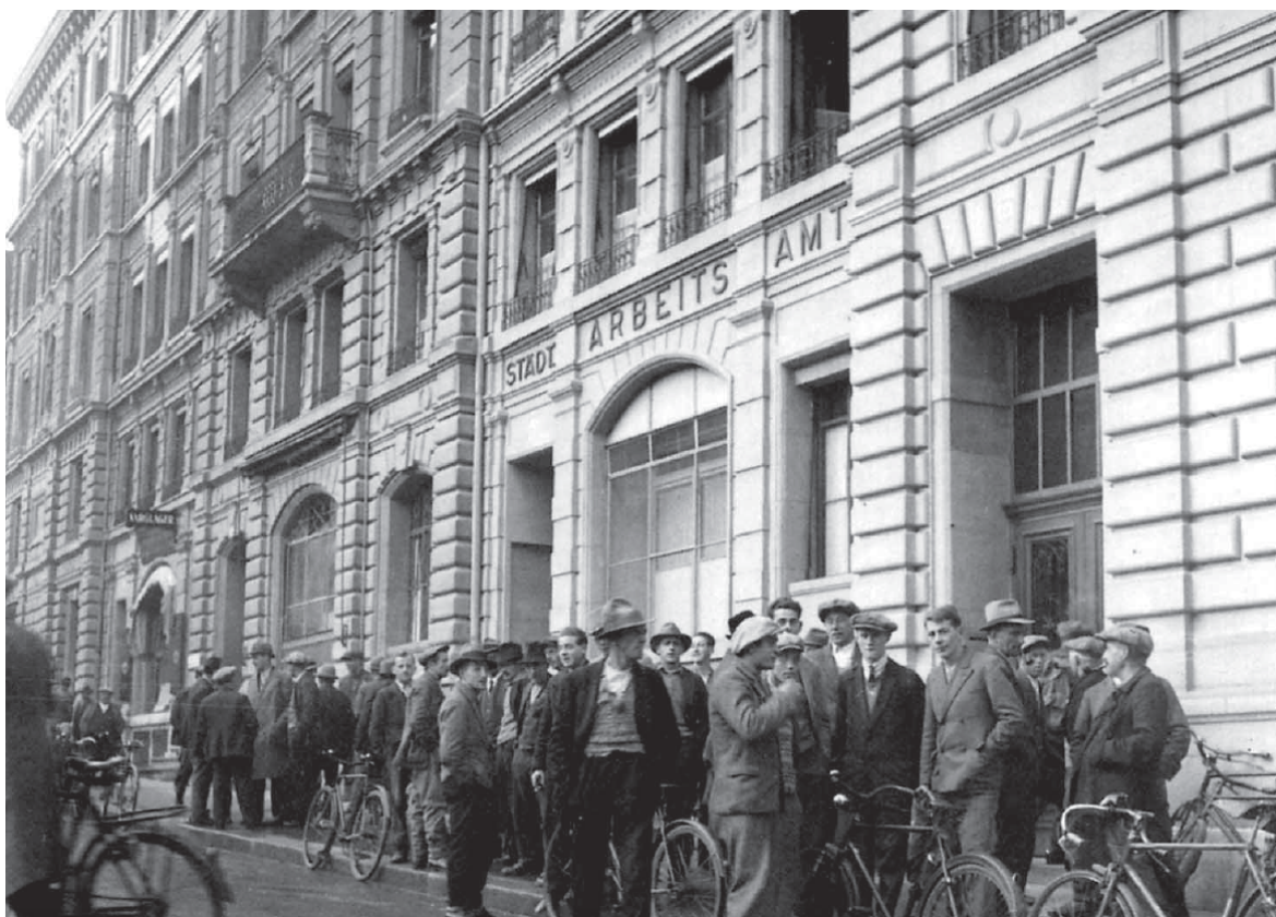
Fassadenansicht Predigergasse 4-10, Archivbild
