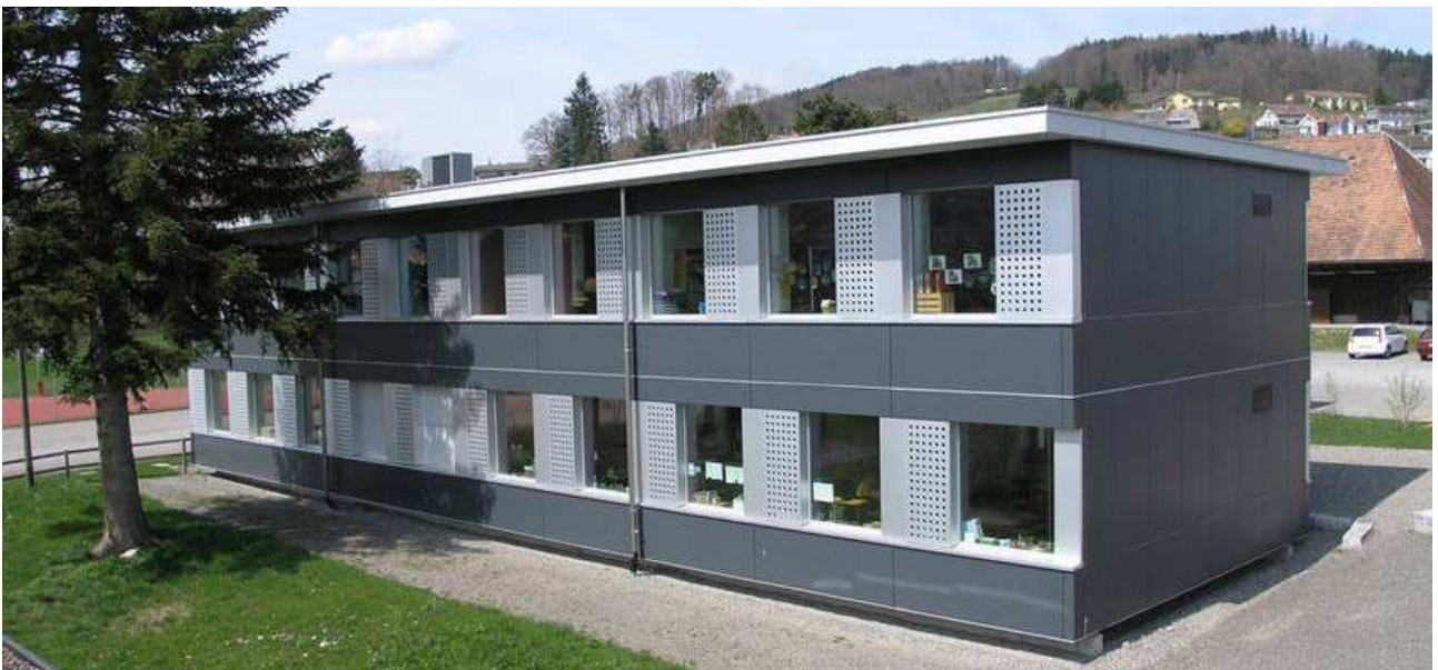
Vergleichbares Objekt mit zwei Geschossen
