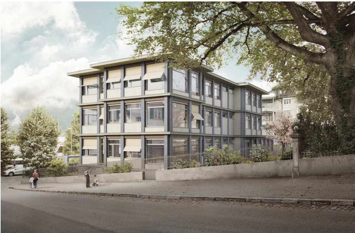
*Visualisierung des Gebäudes von aussen, Blick von Muesmattstrasse in Richtung Bahndepot. Gut sichtbar sind die unterschiedlichen Brüstungshöhen.*
