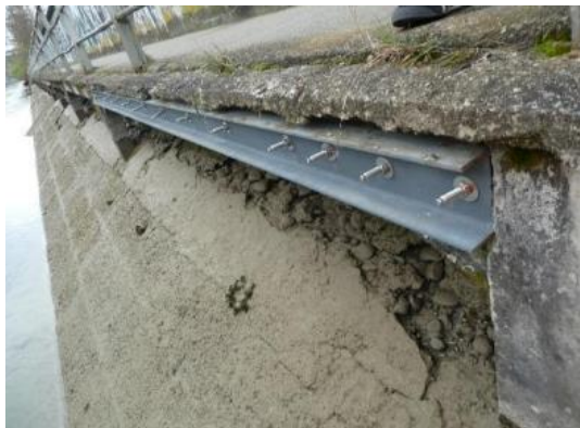
Abb. 3: Sicherung der Gehweg-Lehnenkonstruktion
