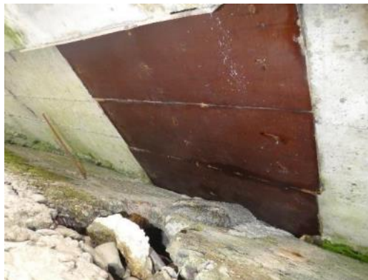
Abb. 4: Verstärkungen im Bereich von Korrosionsschäden
