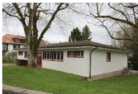
Schulpavillon II an der Forrerstrasse 3
