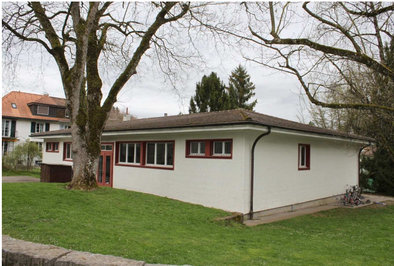
Schulpavillon II an der Forrerstrasse 3, Blick aus Norwesten
