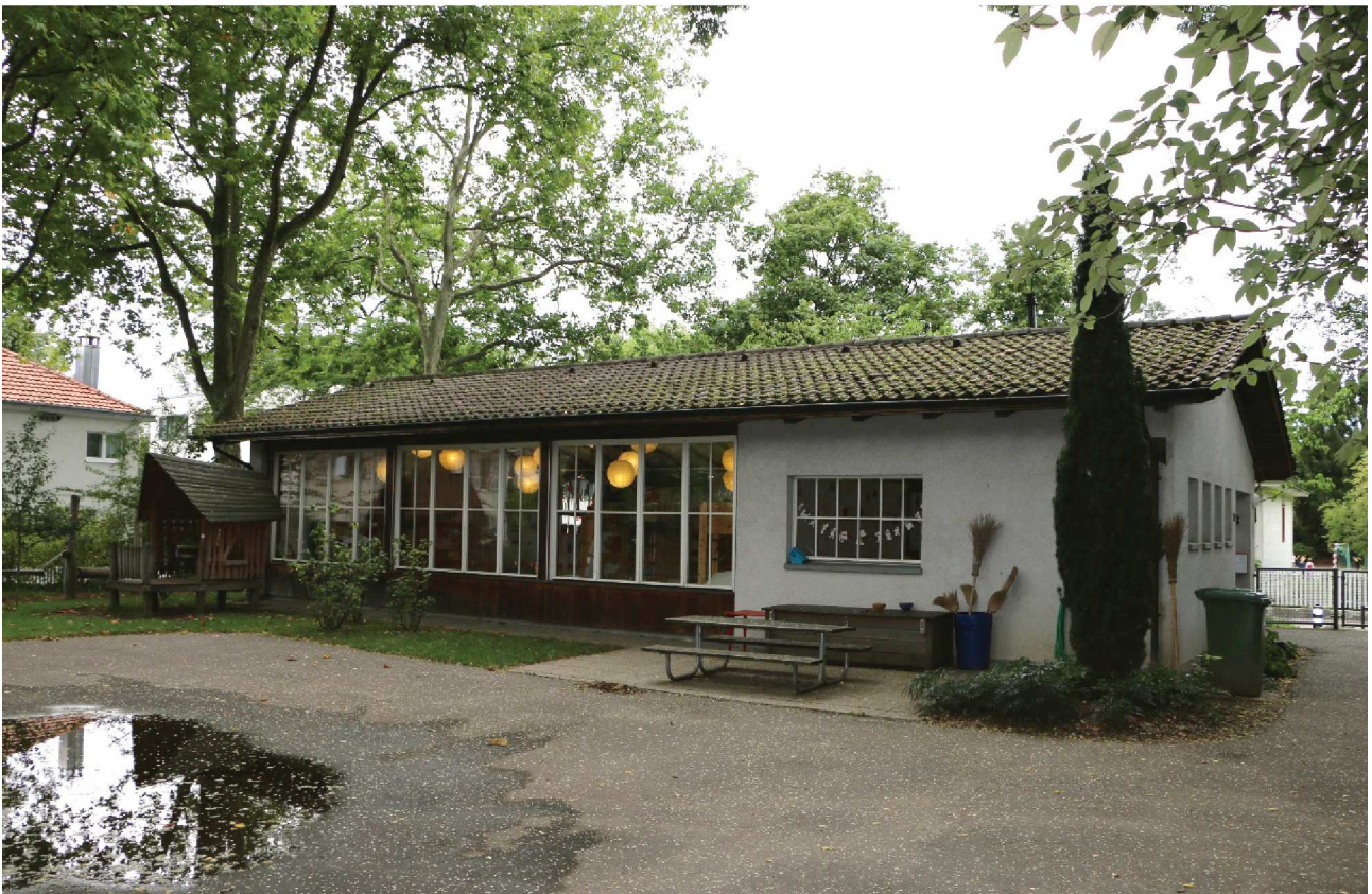
Kindergartenpavillon am Kistlerweg 20, Blick aus Südosten
