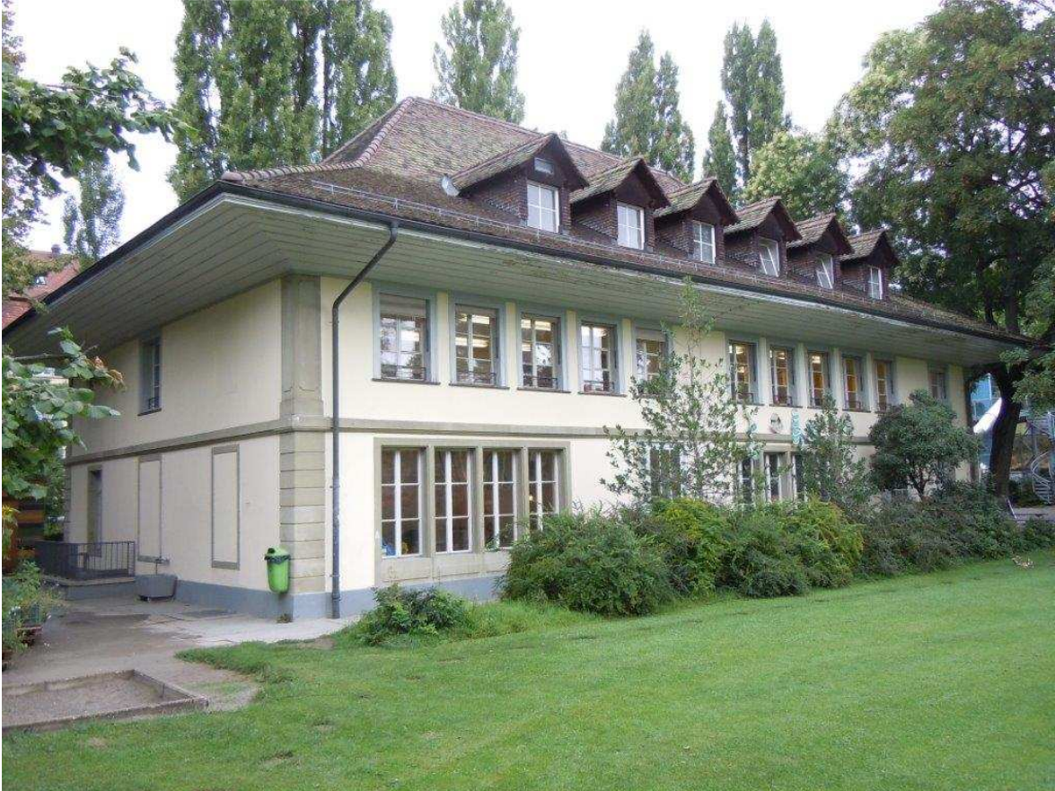
Gebäude Volksschule Steckgut
