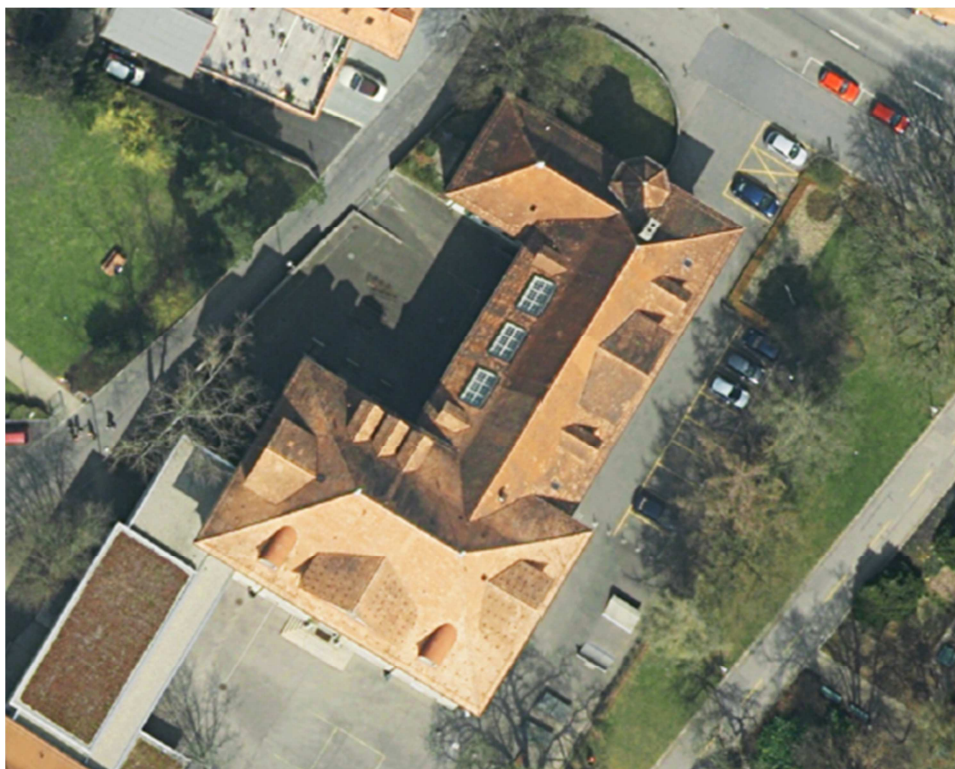
Dachaufsicht Volksschule Bümpliz, Orthofoto
