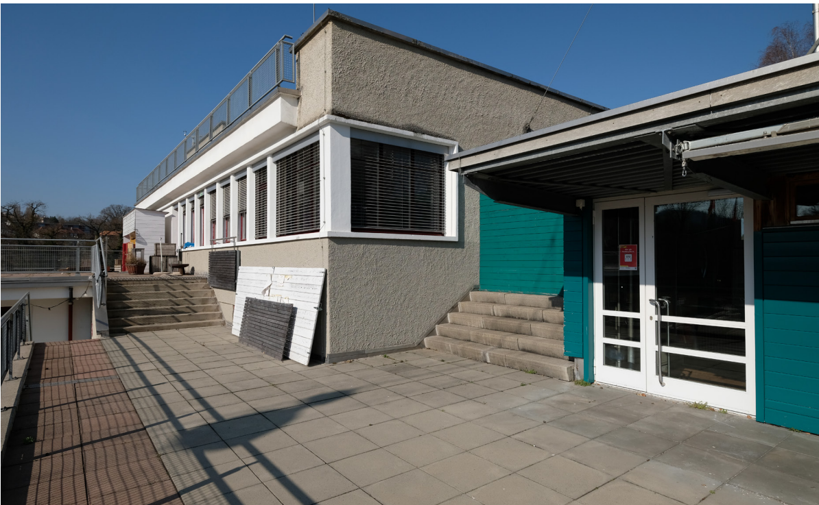
Terrasse Hauptgebäude Obergeschoss
