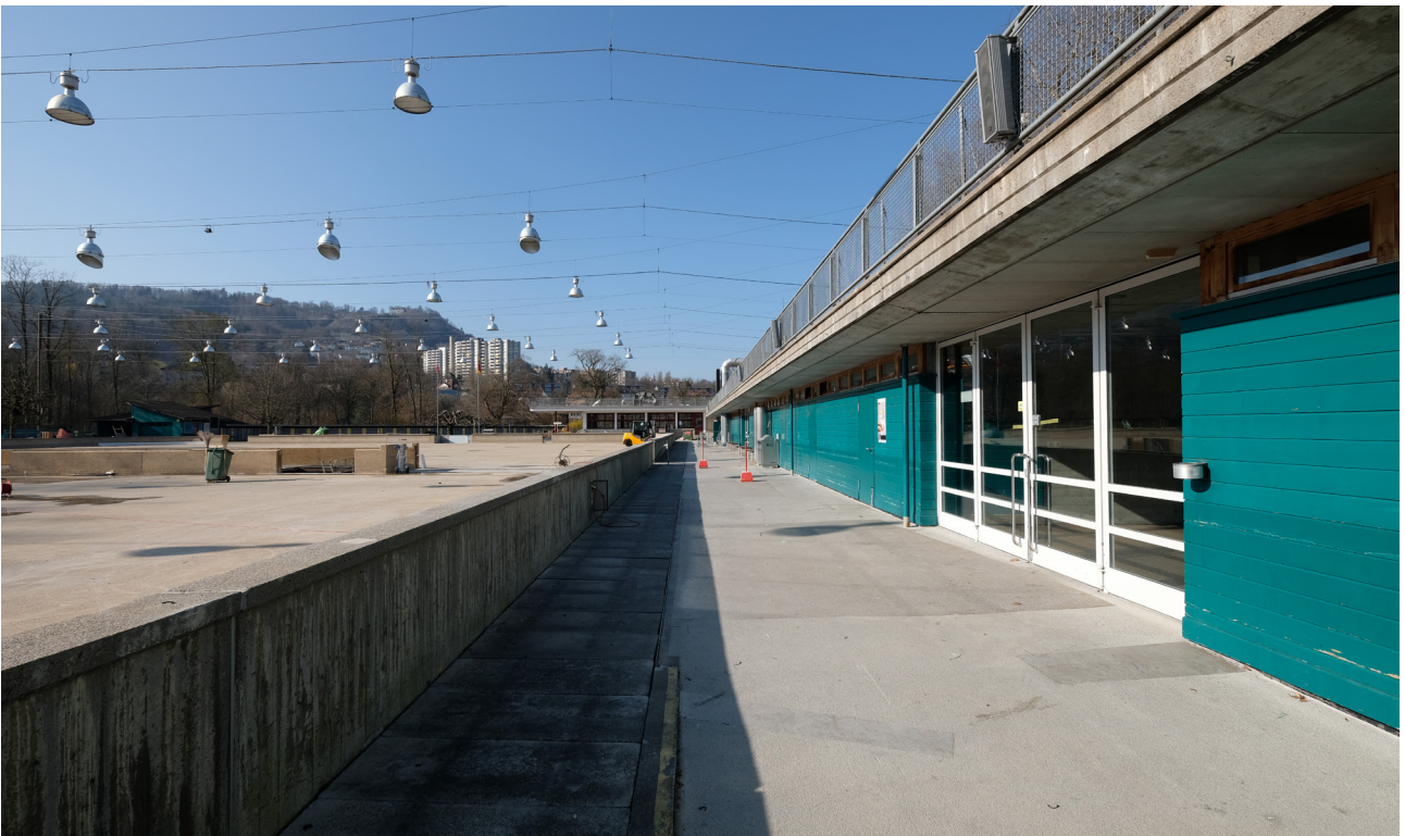
Nichtschwimmbecken und Garderobengebäude Bestand
