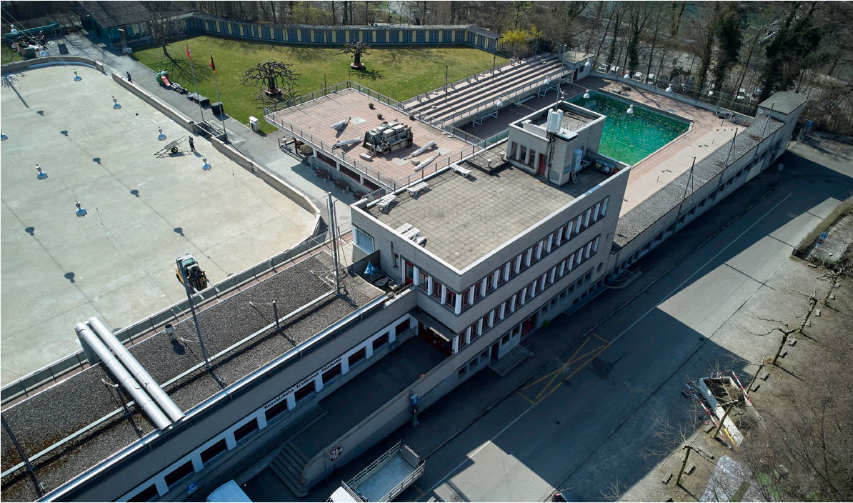
Luftaufnahme Hauptgebäude von Norden
