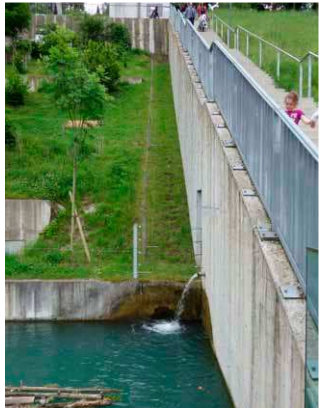
Stützmauer Süd vom Uferweg gesehen
