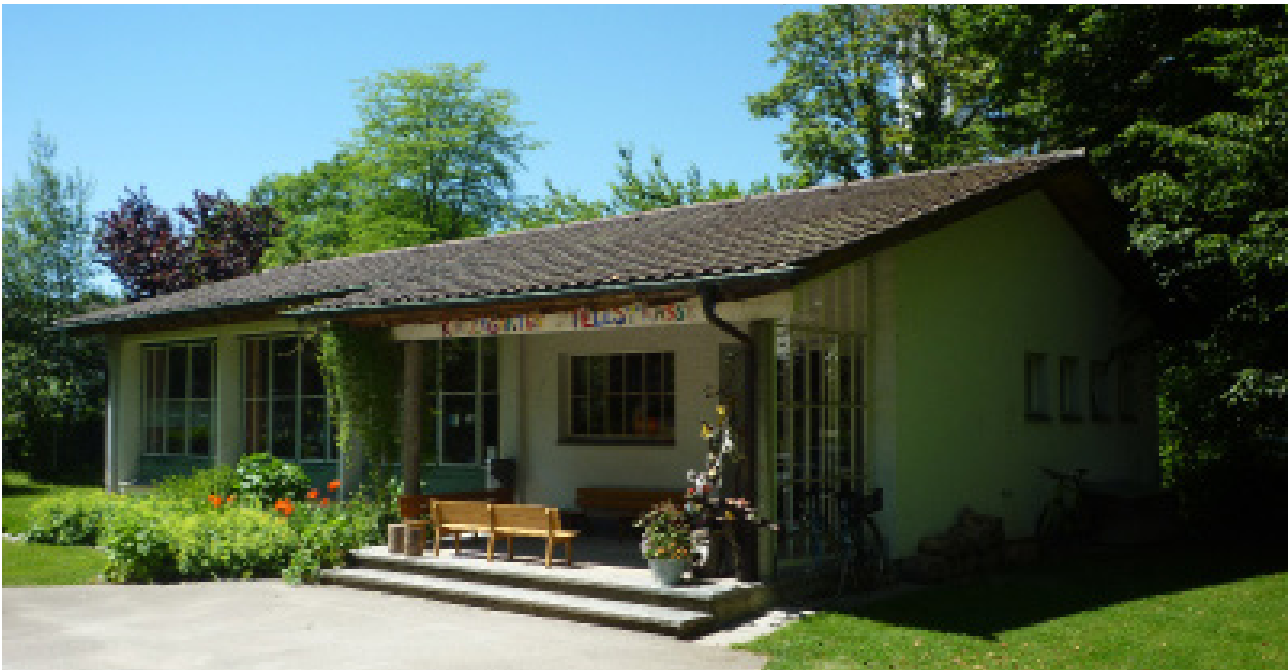
Bestand Tellstrasse Kindergarten
